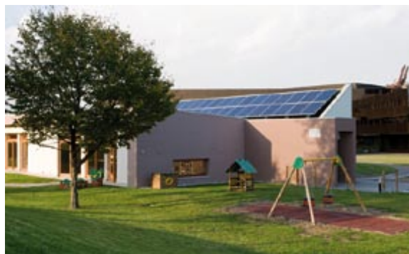
L'asilo nido aziendale di Mogliano Veneto, realizzato con criteri ecosostenibili tra cui un impianto fotovoltaico
